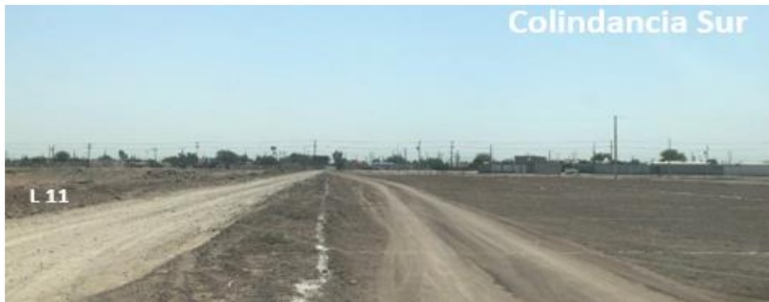
Figura 19.- Colindancia Sur con calle de terracería y predios baldíos.
